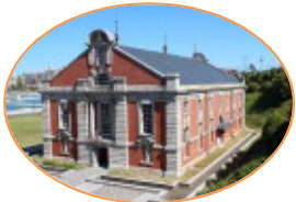
鍋屋上野浄水場 旧第一ポンプ所
