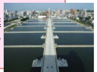
鍋屋上野浄水場 緩速ろ過池
