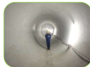
中村西部雨水調整池
