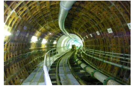
雨水を一時的に貯留する雨水調整池の整備工事
