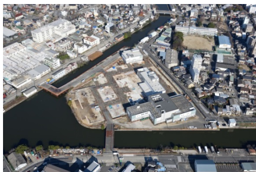
高度処理施設の導入を予定している 露橋水処理センターの改築工事
