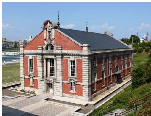
平成 24 年 9 月に名古屋市指定有形文化財に指定された鍋屋上野浄水場旧第一ポンプ所
