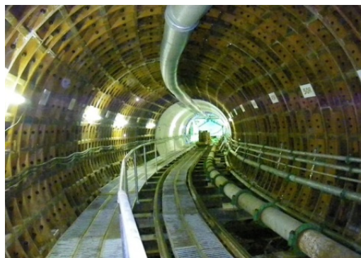
緊急雨水整備事業として建設中の 中村中部雨水調整池の内部
