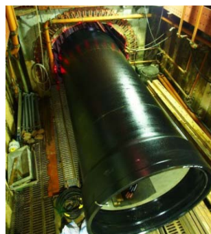
犬山取水場で取水した原水を自然流下によって導水する 犬山系導水路 A 管の工事
