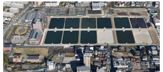
更新した鍋屋上野浄水場の緩速ろ過池
