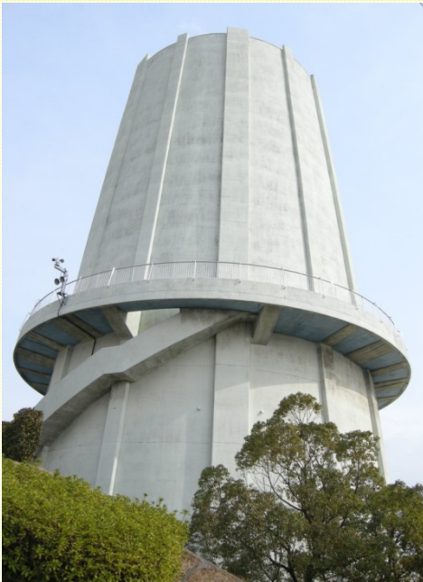
←今回開放された猪高配水塔の外観
