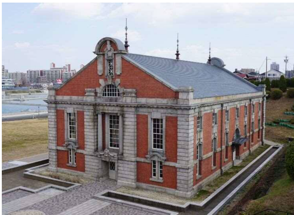
鍋屋上野浄水場旧第1ポンプ所 (名古屋市指定文化財)
