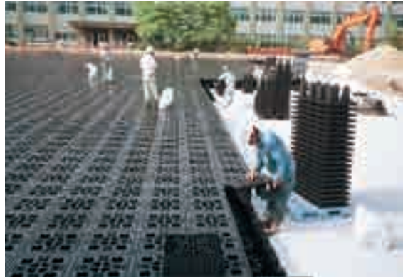
地下貯留施設の建設
