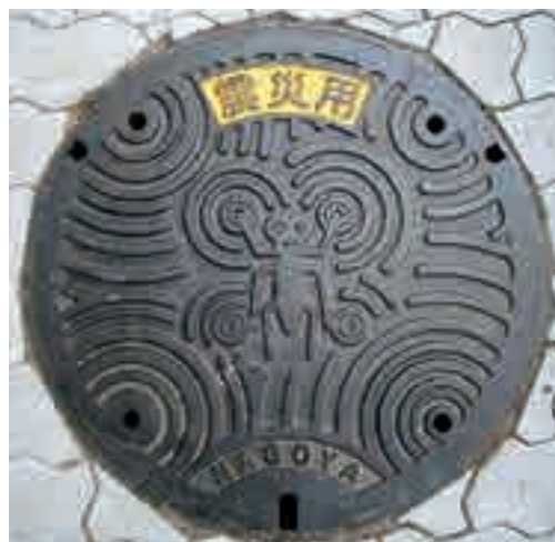
下水道直結式仮設トイレ用マンホール
