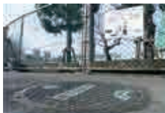
地下式給水栓の設置状況と看板
