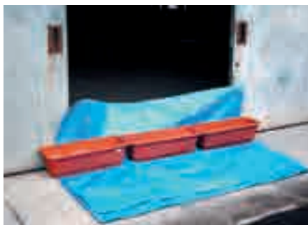
簡易水防工法の例
