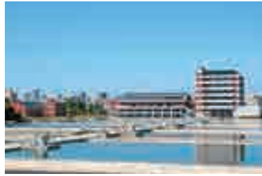
鍋屋上野浄水場
