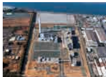
空見スラッジリサイクルセンター
