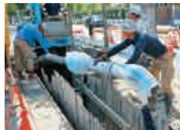
配水管の更新工事
