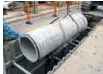
下水管の改築工事
