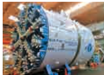
雨水調整池を掘り進めるシールドマシン
