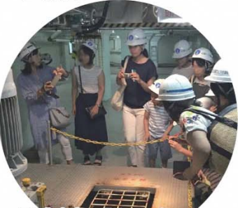
名城水処理センター見学ツアー
