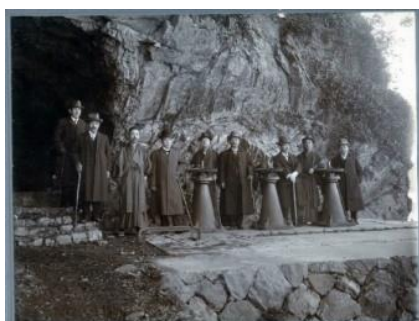
創設時の取水口
