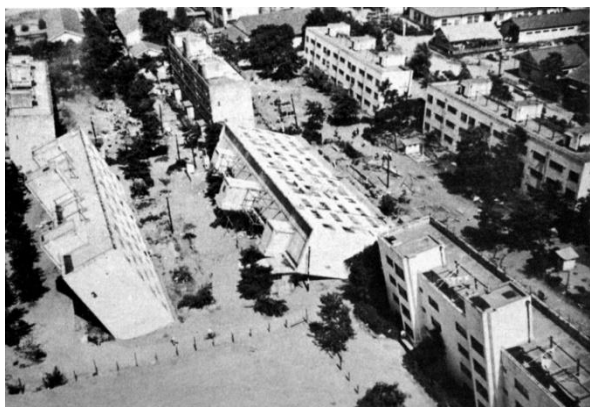
液状化による県営住宅の倒壊
