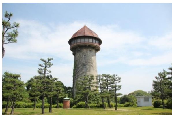
現在の東山給水塔
