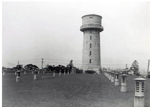
建設時の東山配水塔
