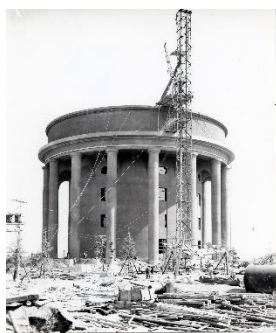
建設中の稲葉地配水塔
