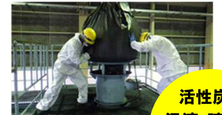
現況施設による活性炭注入作業
