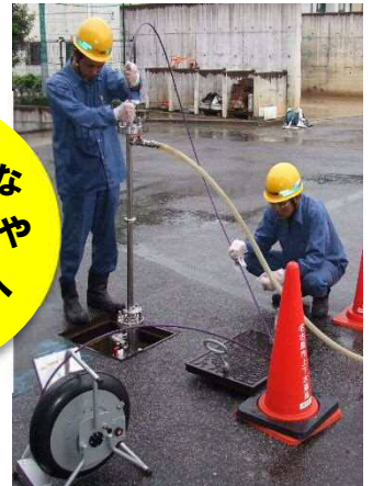
配水管の維持管理作業
