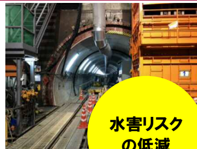
名古屋中央雨水調整池の建設現場
