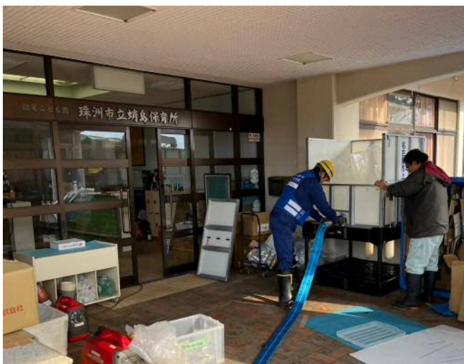
1月6日(土) 応急給水槽(組立式)の 設置の様子(珠洲市)
