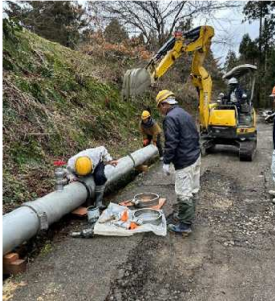
送水管の仮配管工事の様子
