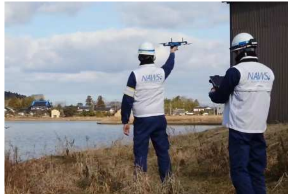
ドローンを活用した漏水調査の様子
