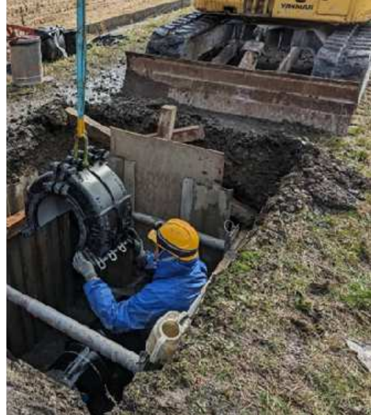
送水管の漏水修理の様子
