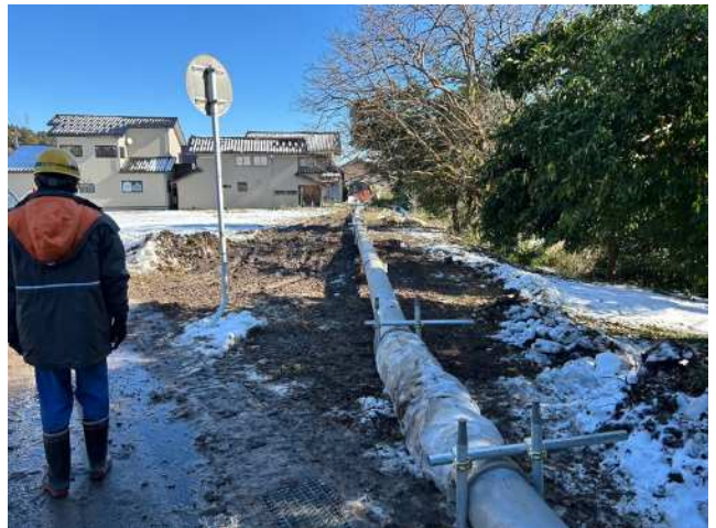
仮設導水管の設置(令和6年1月)
