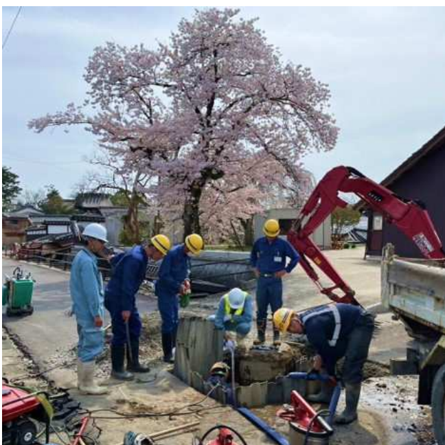
配水管の修繕(令和6年4月)
