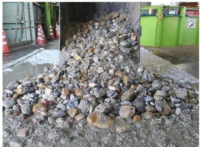
写真2 シールドマシンから排出された石の状況
